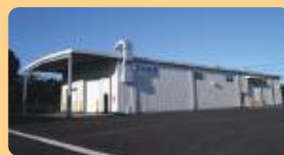
⑤肥料・農薬 倉庫棟 面積：592.73㎡
